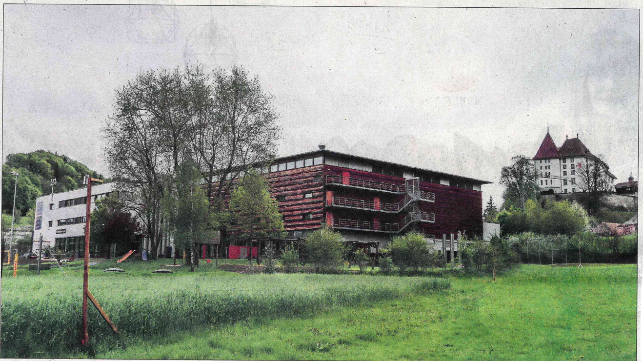
Die geplante Pumptrackanlage kommt in unmittelbarer Nähe zum Forum Sumiswald zu stehen.
